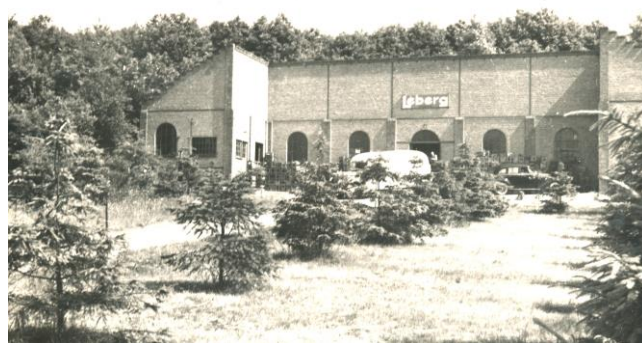
De fabriek zoals ze begin jaren dertig oprees op de flanken van Lébergberg'.
