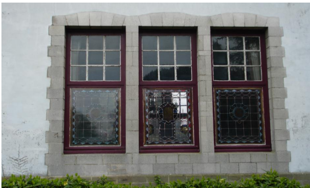
Ramen uit brandglas (bureel) aan de rechterkant van de voorgevel
